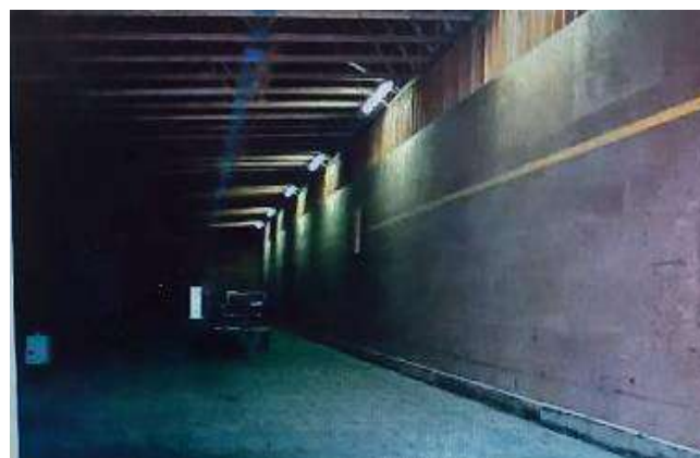
Ilustración 4. 127. Instalación de ventilación forzada.
